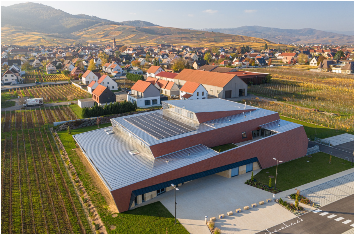
Installation photovoltaïque de 36kWc.
