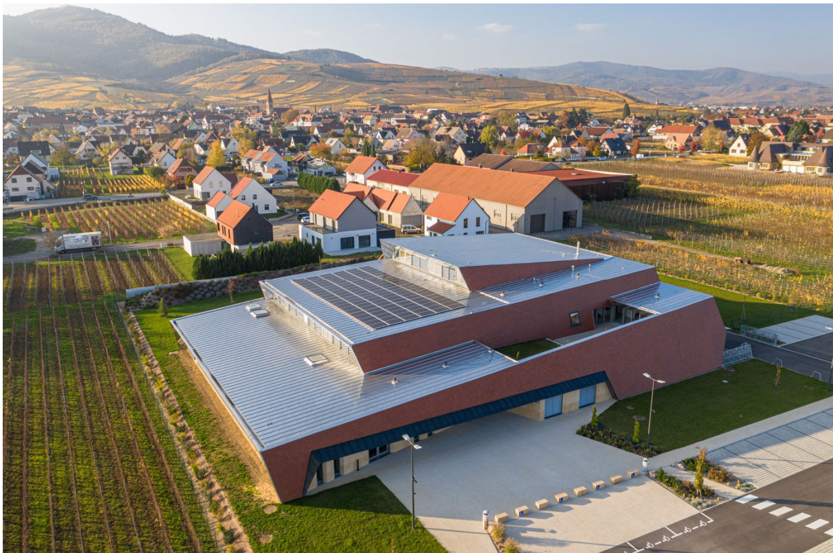
Installation photovoltaïque de 36kWc.
